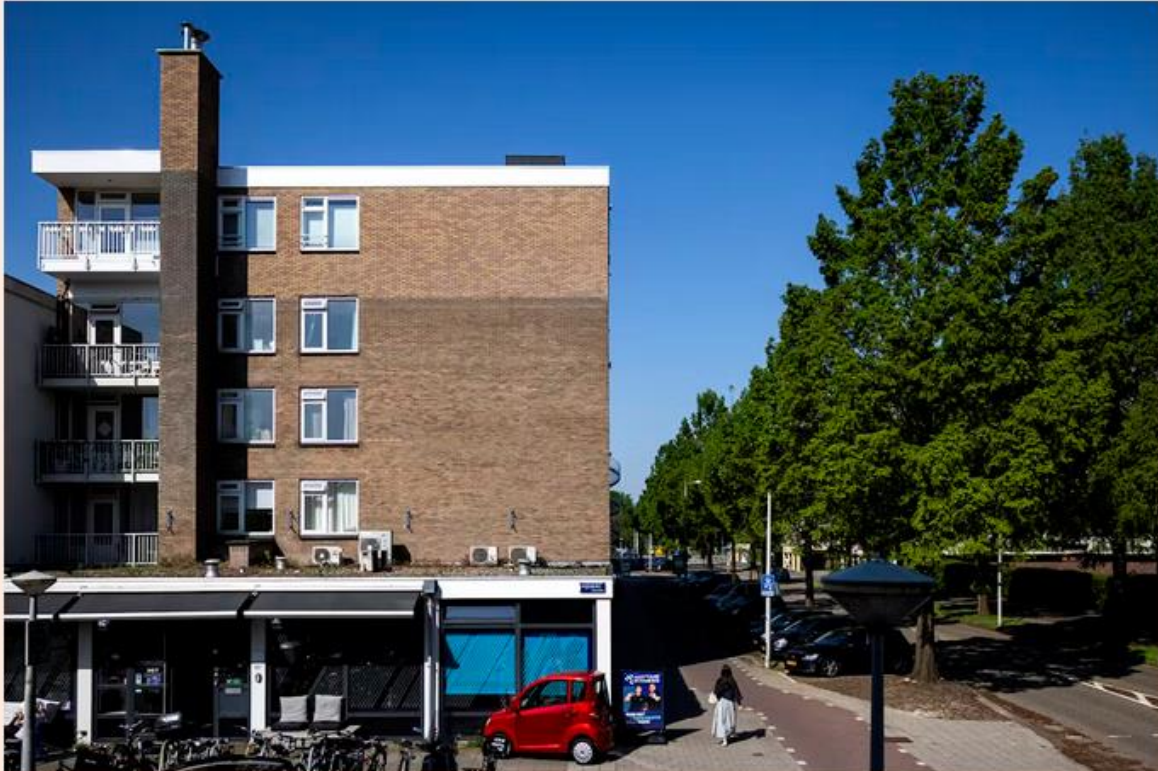
Een woonblok in de Arent Janszoon Ernststraat in Amsterdam Buitenveldert kreeg er een woonlaag bij. Foto: Ramon van Flymen voor het FD
