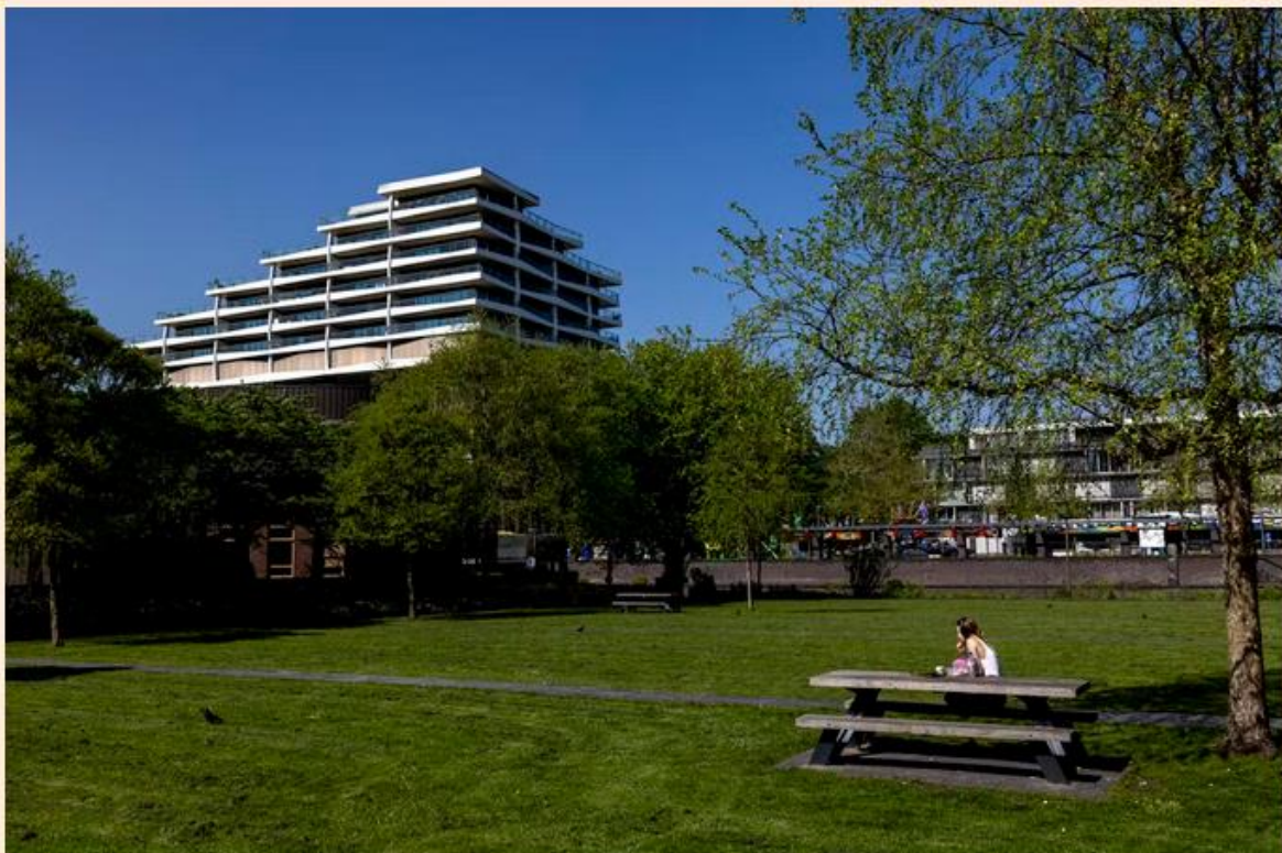
Appartementencomplex UpMountain in Amstelveen, gebouwd bovenop een parkeergarage. Foto: Ramon van Flymen voor het FD
